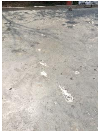
Agrietamientos y pérdida de mortero en la superficie de la capa de rodadura de los pavimentos
