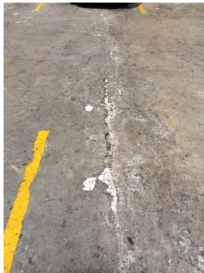
Agrietamientos y pérdida de mortero en la superficie de la capa de rodadura de los pavimentos
