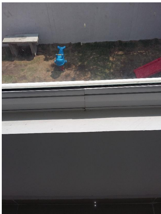
(Junta entre perfiles de aluminio sin sello)
